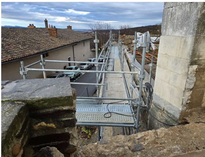
Section du mur du parvis enlevé pour préparer l'arrimage de la passerelle
