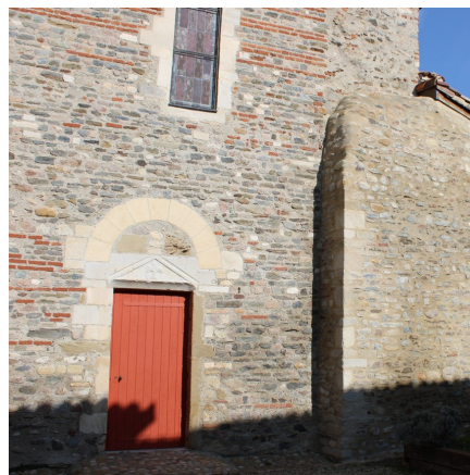
mur antérieur accolé à l'église du XIIe siècle
