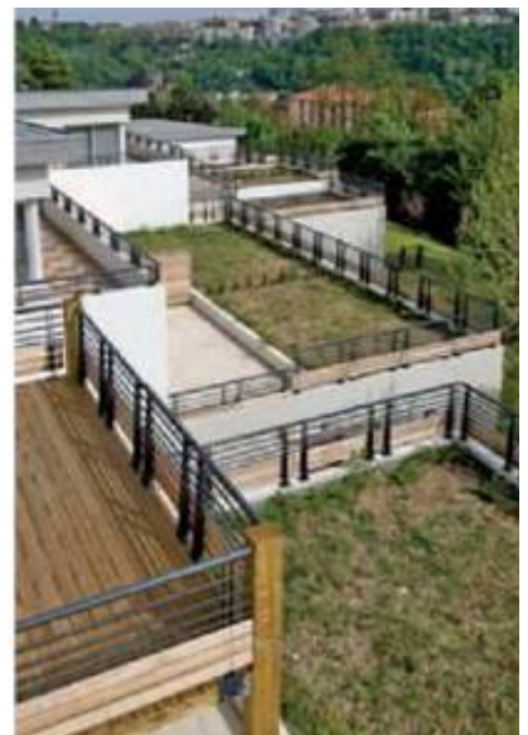
Toiture terrasse végétalisée, pour une meilleure gestion des eaux pluviales et de la thermique des bâtiments. Réf : Photo de l'agence d'urbanisme de Lyon, Issue du DOG du SCOT.
